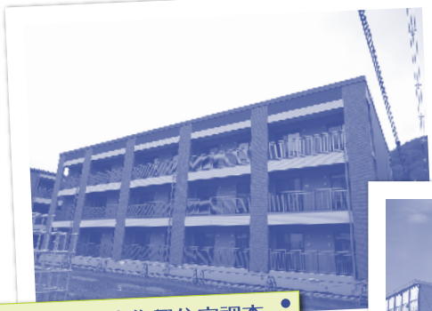
釜石市災害復興住宅調査 平成25年4月8日
